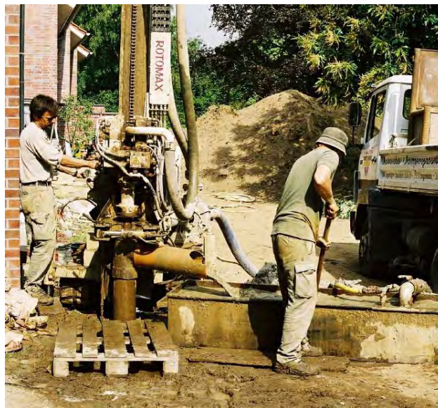
Бурение скважины земляного зонда при помощи стационарного бурильного станка
