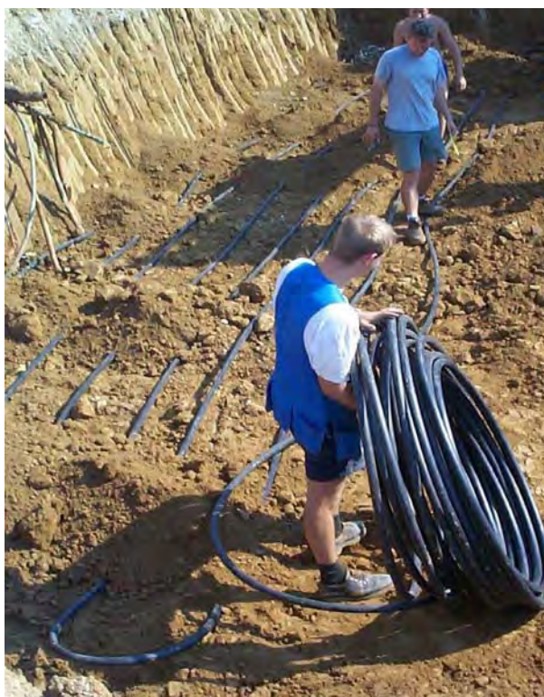
Прокладка земельного коллектора
