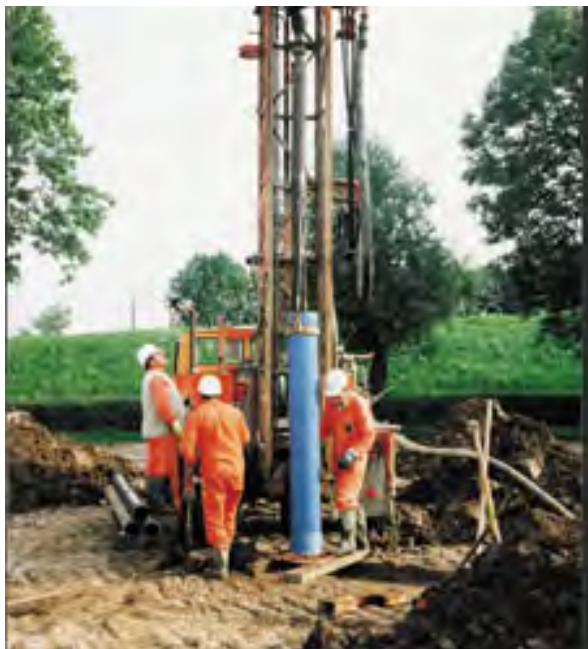
Бурение системы скважин
