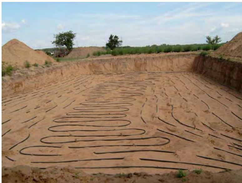
Земляной коллектор перед засыпкой песком
